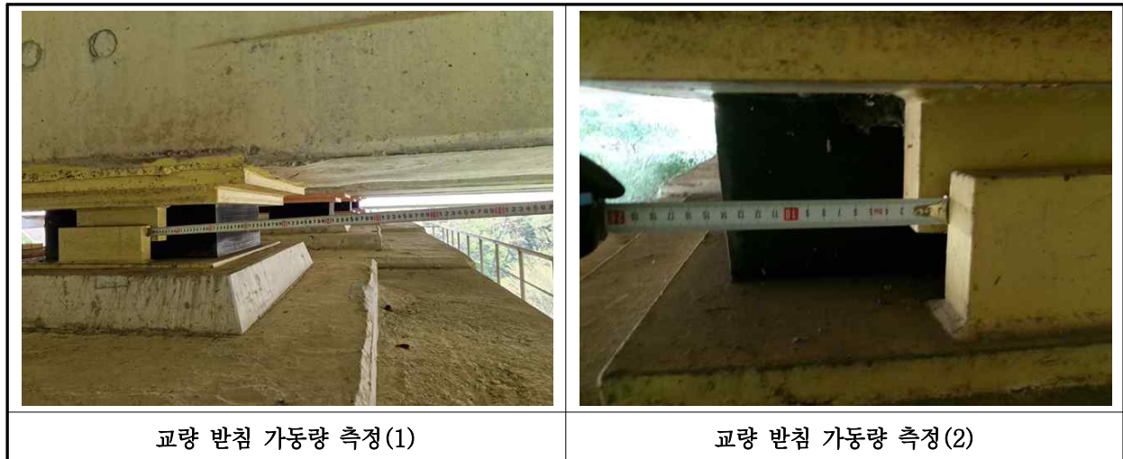
【사진 13.3.16】 교량받침 이동량 측정
