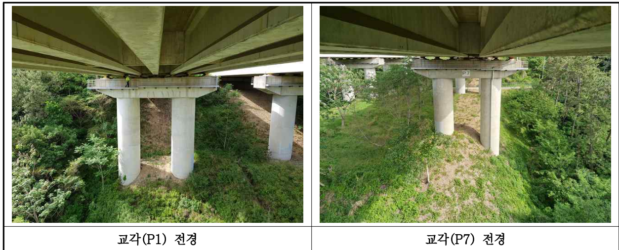
【사진 13.3.10】 교각 전경
