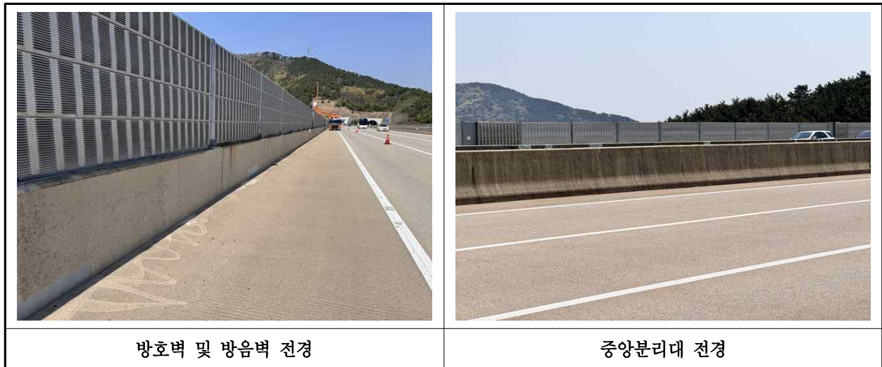
【사진 13.3.24】 방호벽 및 중분대 전경
