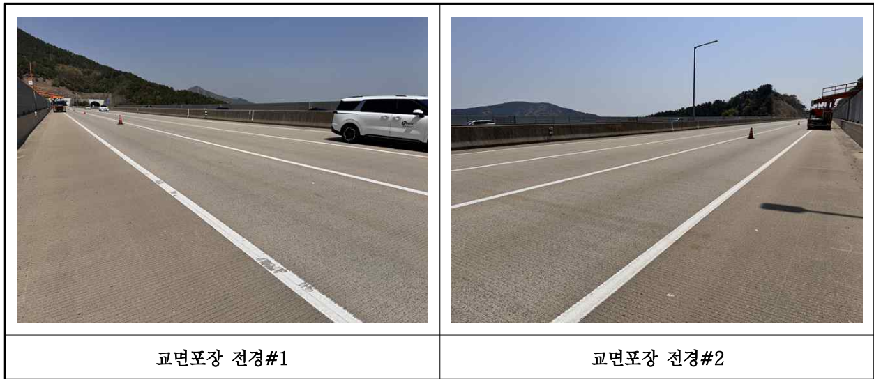
【사진 13.3.20】 교면포장 전경
