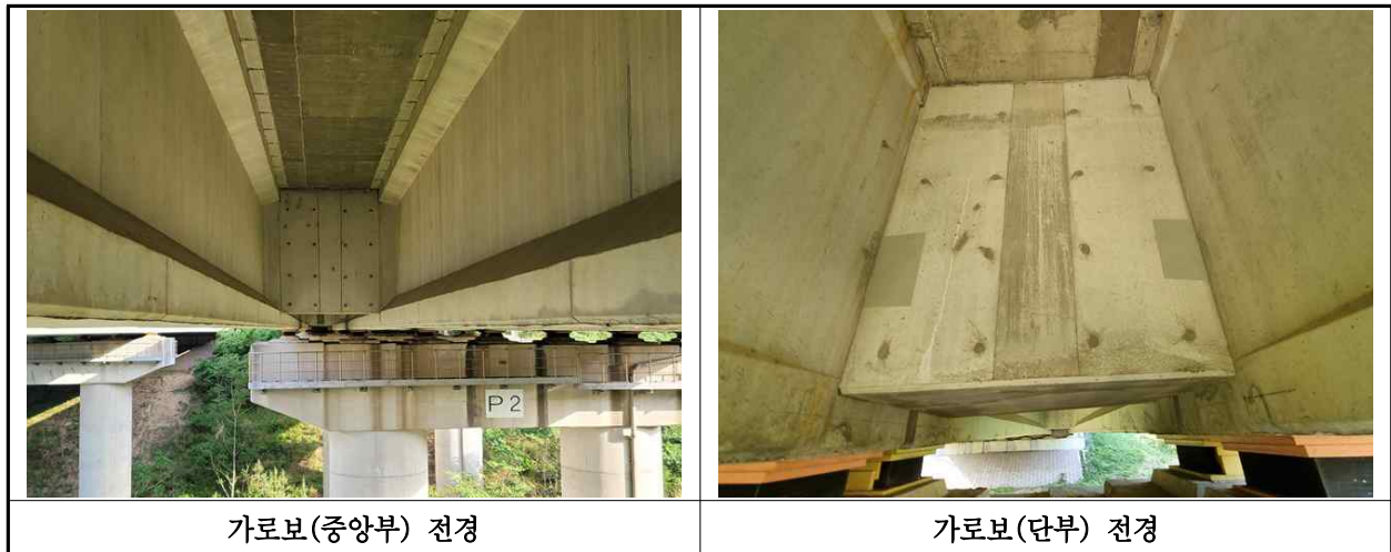
【사진 13.3.6】 가로보 전경
