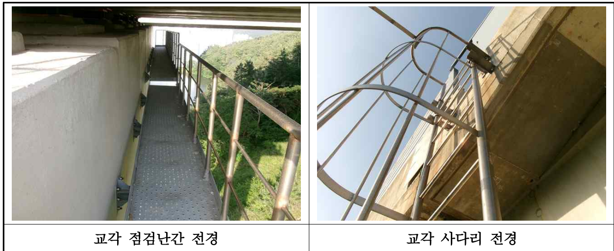
【사진 13.3.26】 교량 점검시설 전경
