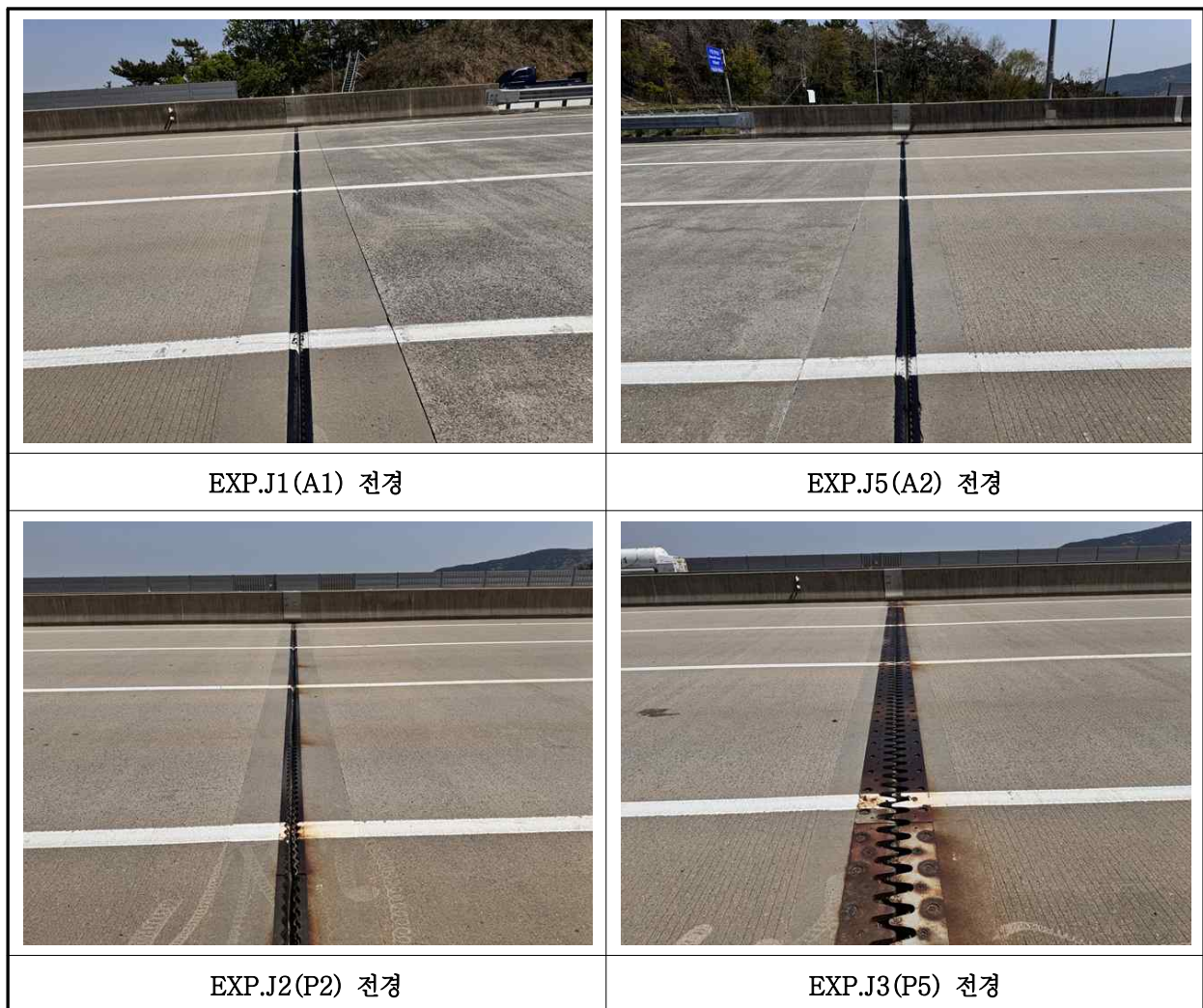
【사진 13.3.17】 신축이음장치 전경
