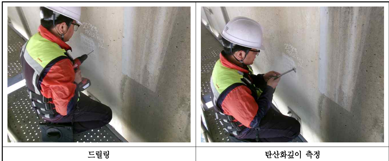
【사진 13.4.3】 탄산화 깊이 측정 현장사진
