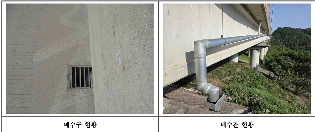
【사진 13.3.22】 배수시설 전경
