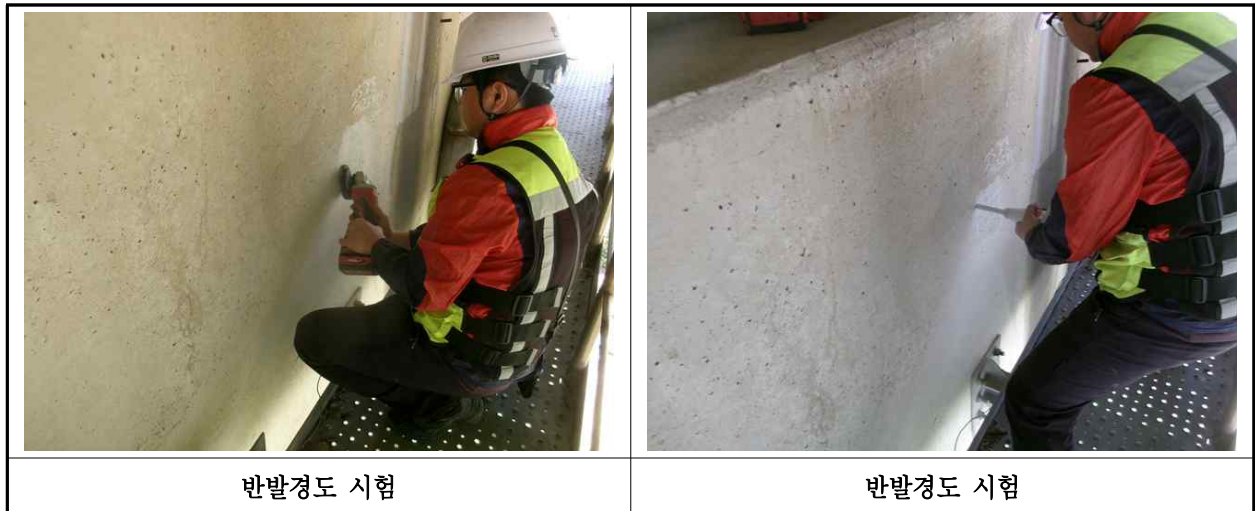
【사진 13.4.2】 반발경도시험 현장사진
