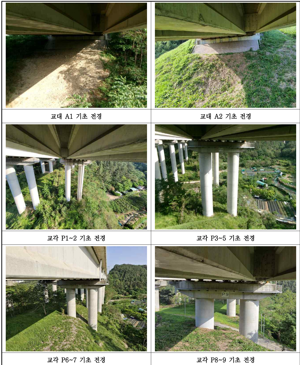
【사진 13.3.12】 기초 전경
